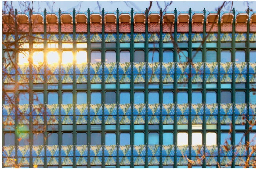
Abb. 7: Bundesamtsgebäude Radetzkystraße 2, Wien, Fenster der Bürogoschosse, 2025
